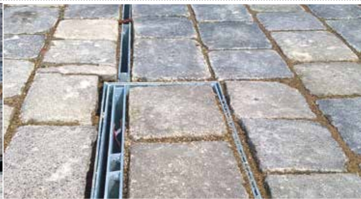
2 FOTO DELLA GRIGLIA A POZZETTO
